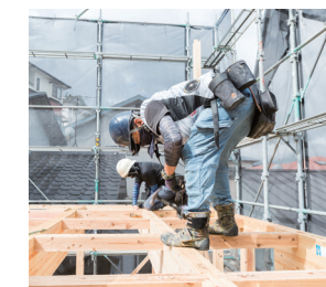
▲ 大工工事③
