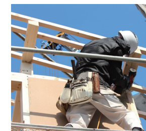
▲ 大工工事①
