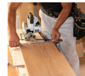
▲ 大工工事②
